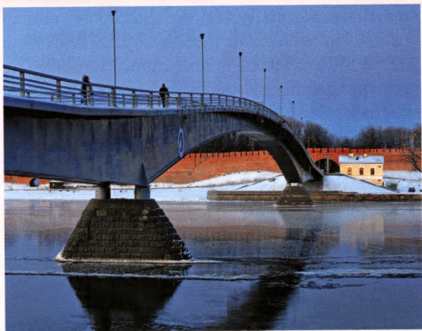
Пешеходный мост через Волхов
