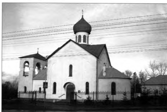
Вид с юга после реставрации. Фото 2007 г.
