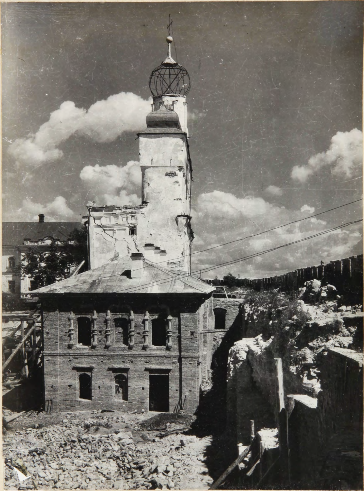
Кремль. Звонница Софийского собора и домик XVII века при нем. Вид с юга. Реставрационные работы 1946 г.
