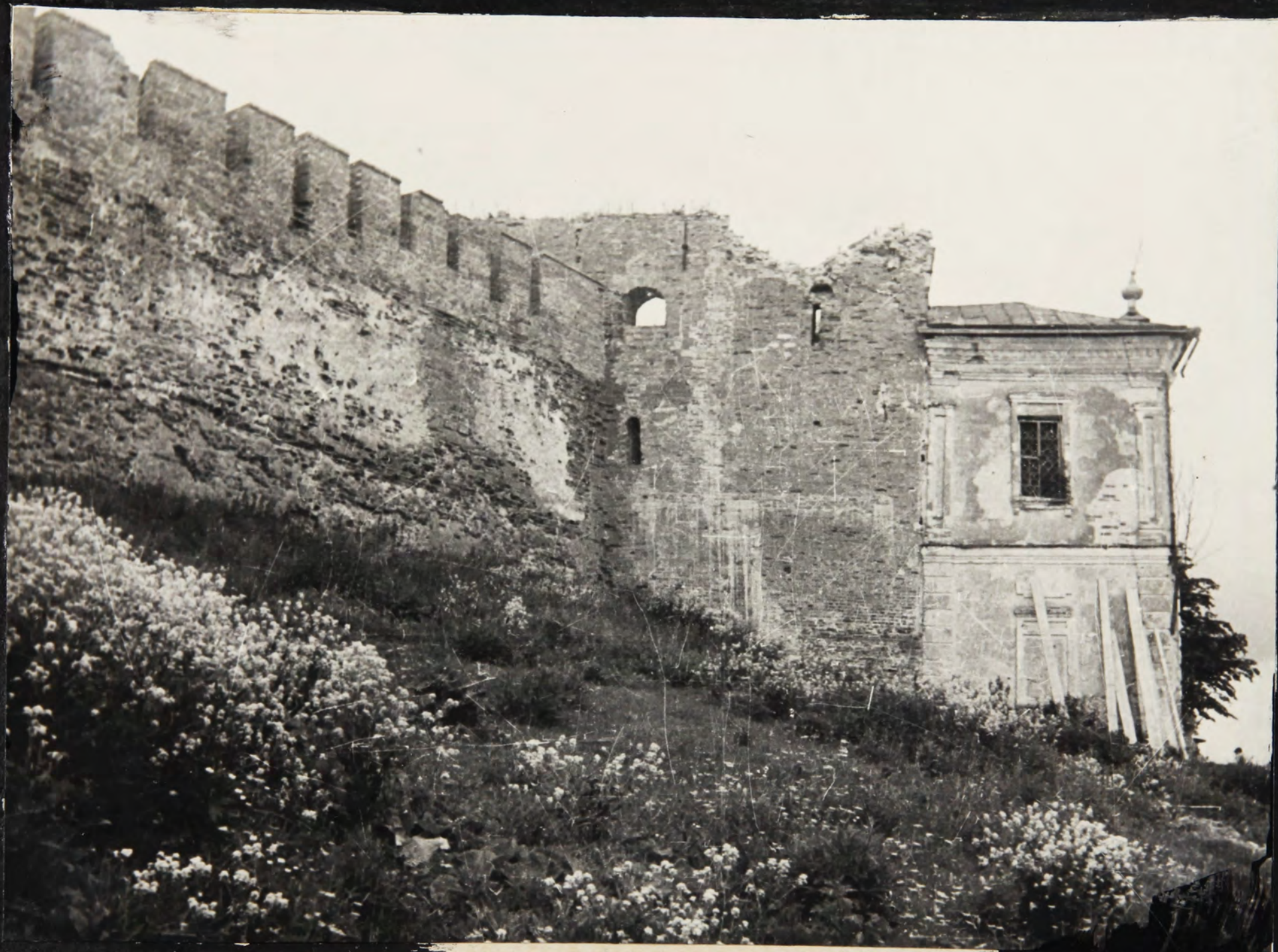
Владимирская башня. Вид с юго-востока
