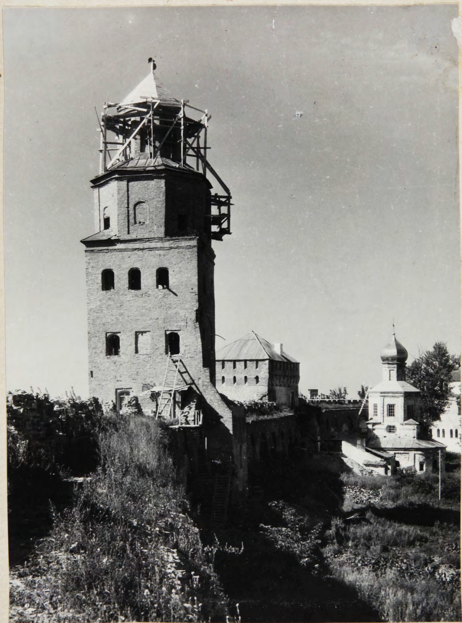
Башня Кокуй. Вид с юга. Реставрационные работы. июль-август 1947 г.
