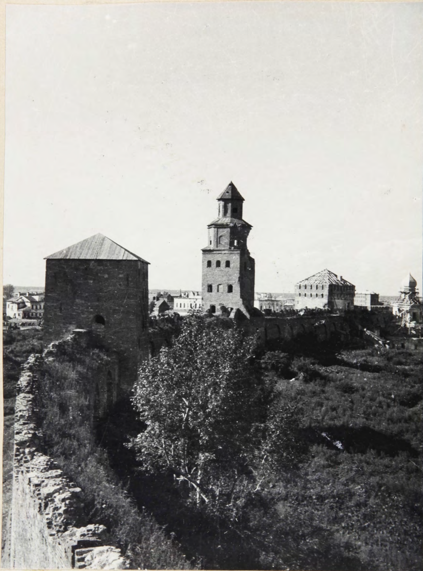
Часть кремлёвской стены. Начало реставрации.
