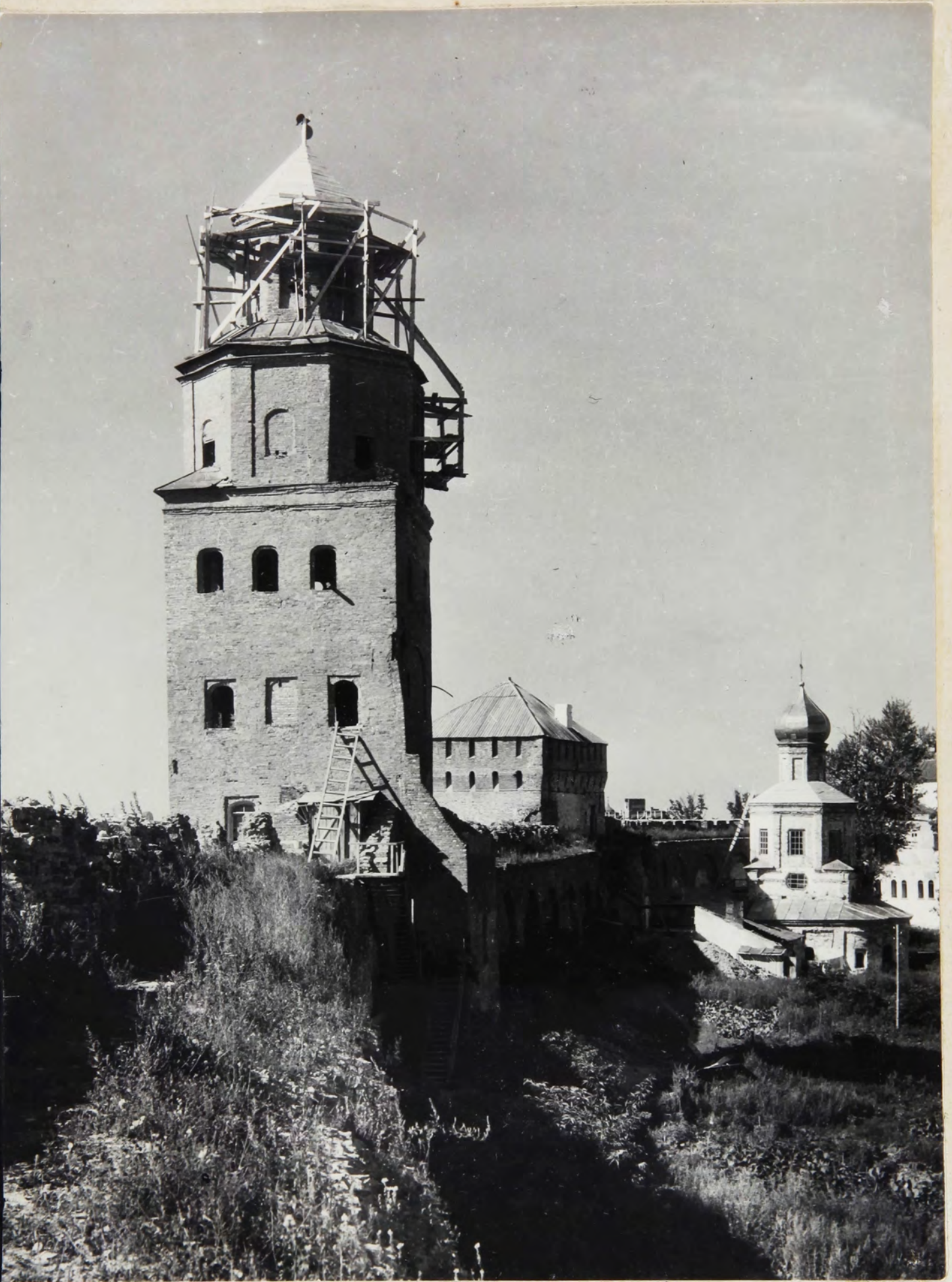
Кремль. Башня Кокуй в период реставрации.
