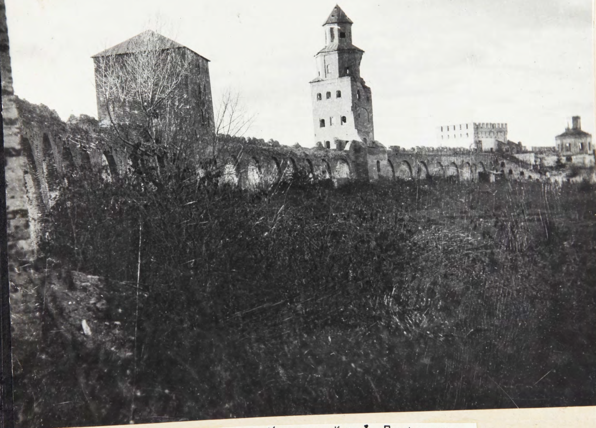
Кремль. Башни Княжеская, Кокуй, Покровская до реставрации.
