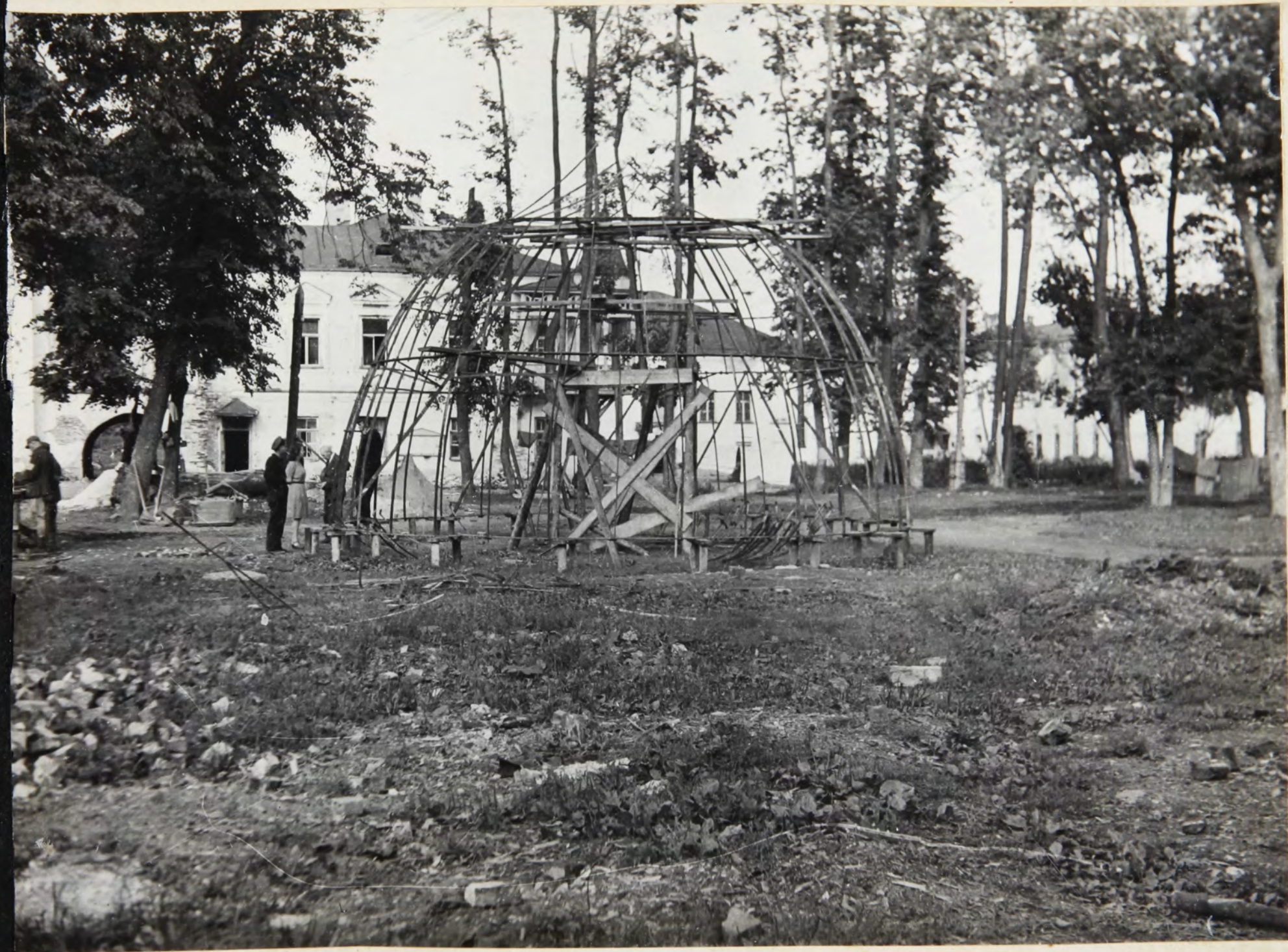
Кремль. Монтаж каркаса центральной главы Софийского собора. сентябрь 1946 г.
