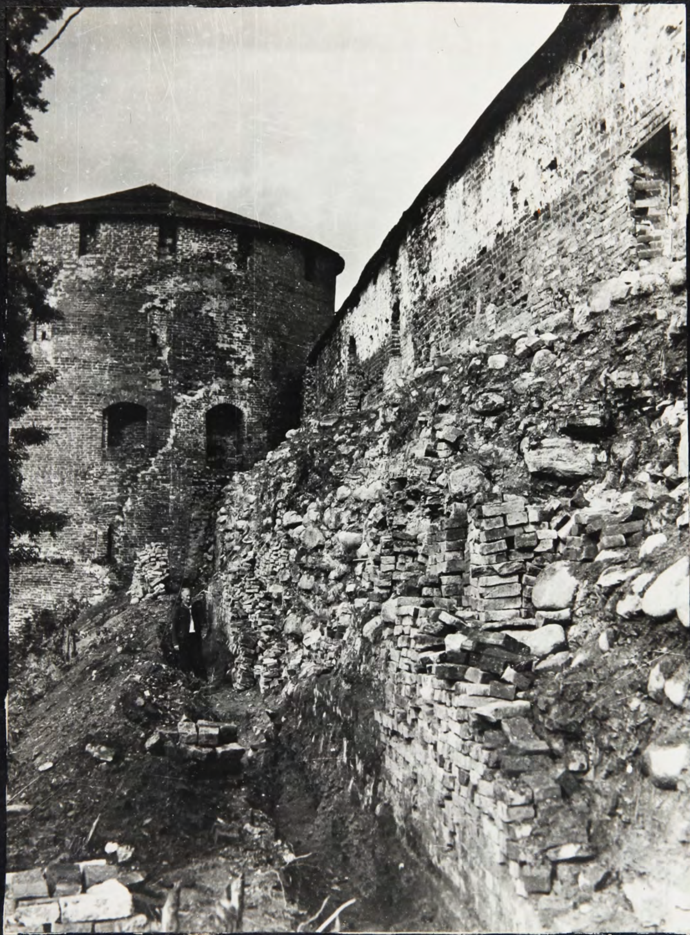
Кремлевская стена за Лихудовым корпусом. Вид с юга перед началом восстановительных работ 1946 г.
