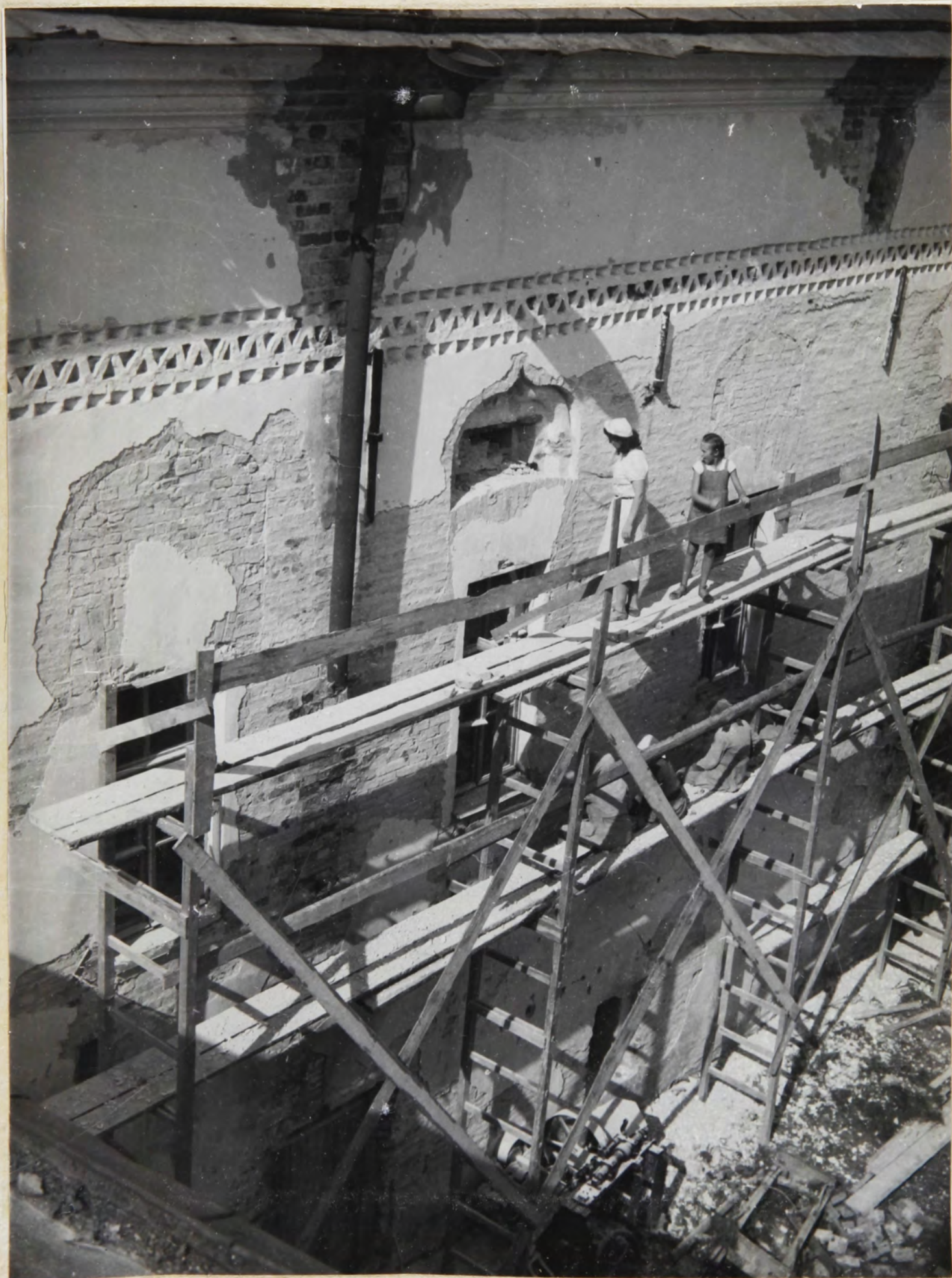
Архиепископский дворец. Работы по реставрации фасада. Август 1946 г.
