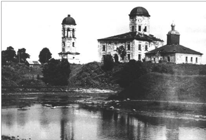
Буреги. Храмовый комплекс. Вид с юго-запада. Фото 1970-х гг.
